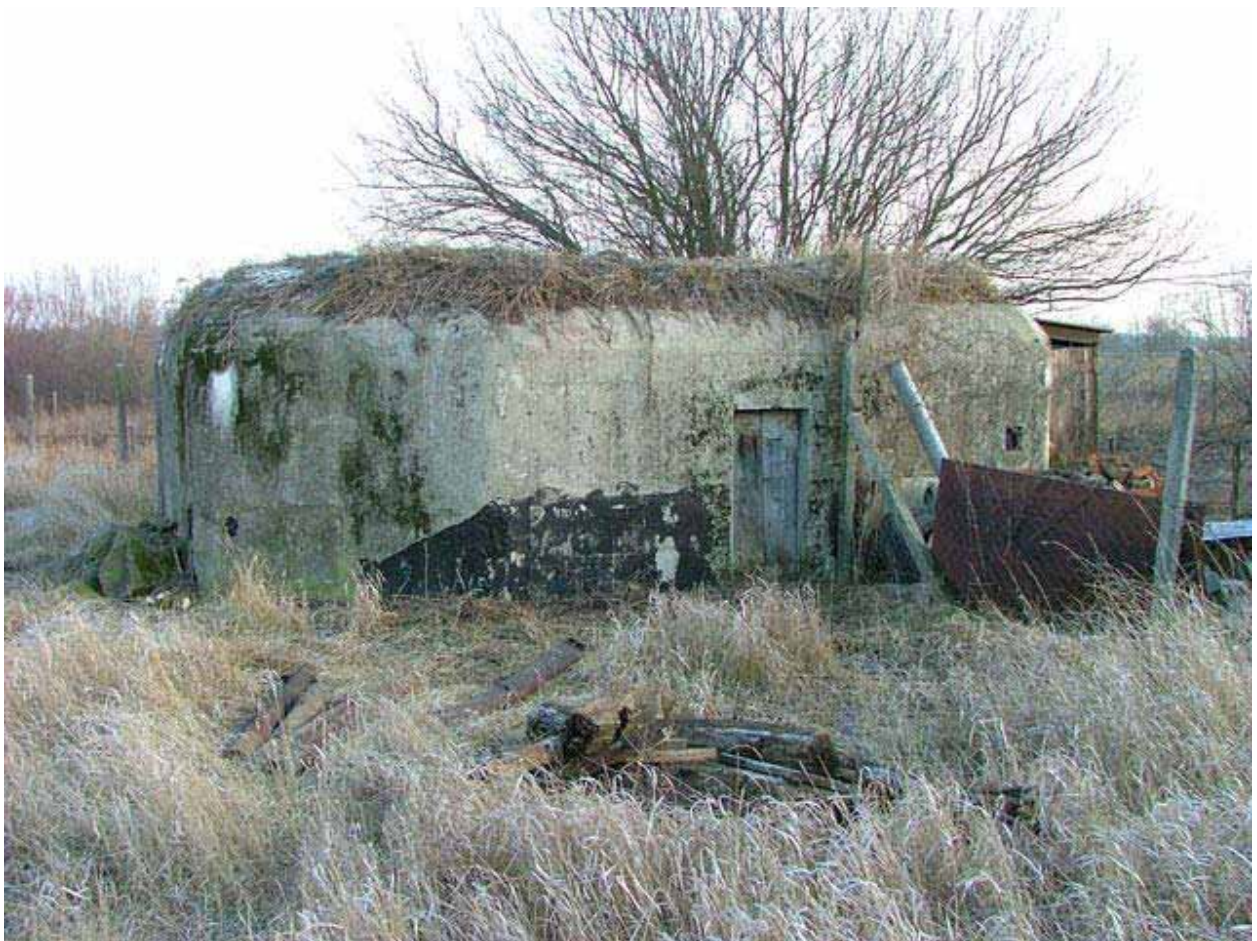
Csehszlovák betonbunker maradványa (Önkormányzat tulajdona)
